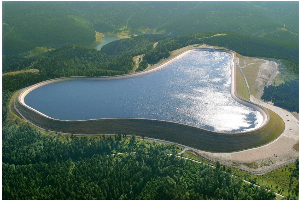
Goldhistal pumpkraftverk i Thuringen. 1060 MW. Ägare Vattenfall
