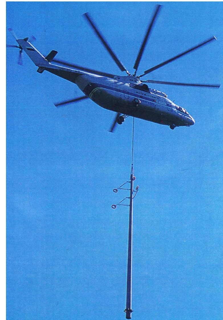
Världens största helikopter, ryska MI-26 Sätter ut 130 kV stolpar i Västsverige
